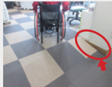
バリアフリー対応の事務室入口 わずかな段差だがスロープを設置している
