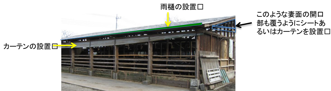
図3 カーテン、雨樋の設置
