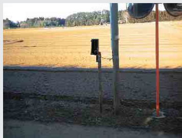
交通量の多い道路を挟んで牧場や飼料畑があります。作業者の飛出し防止のため、道路を挟んで光センサーを設置しています。
