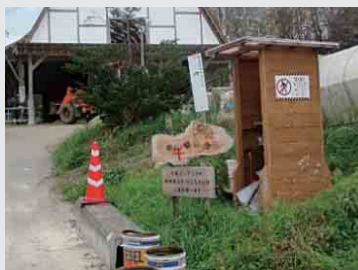
進入禁止の表示
