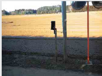
交通量の多い道路を挟んで牧場や飼料畑があります。 作業者の飛出し防止のため、道路を挟んで光センサーを設置しています。 (写真提供：千葉県畜産協会)
